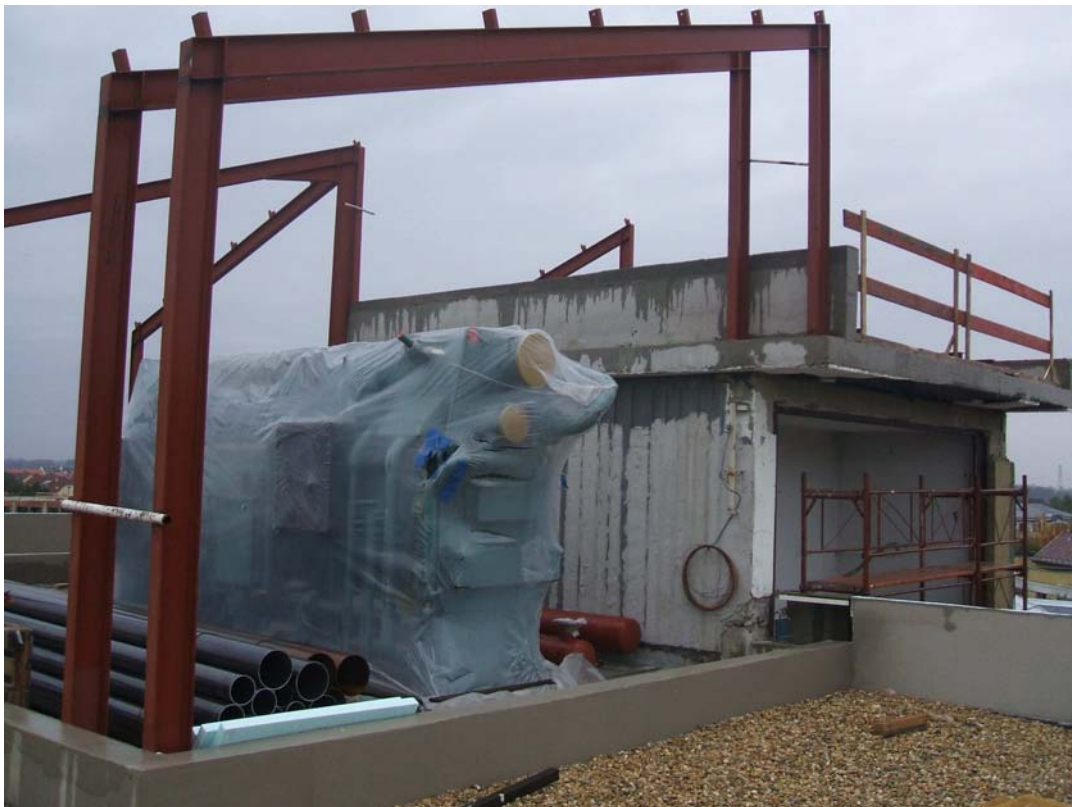
Az abszorpciós folyadékűtő tetőre helyezése
