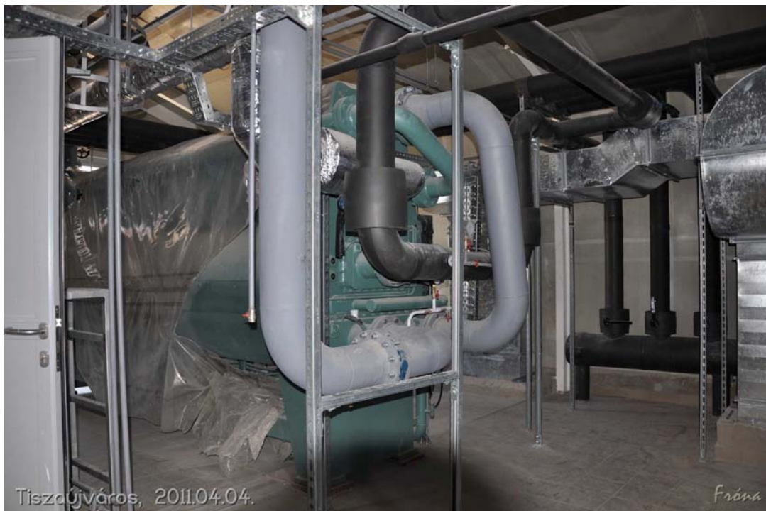
A hűtőközpont üzembe helyezést megelőzően
