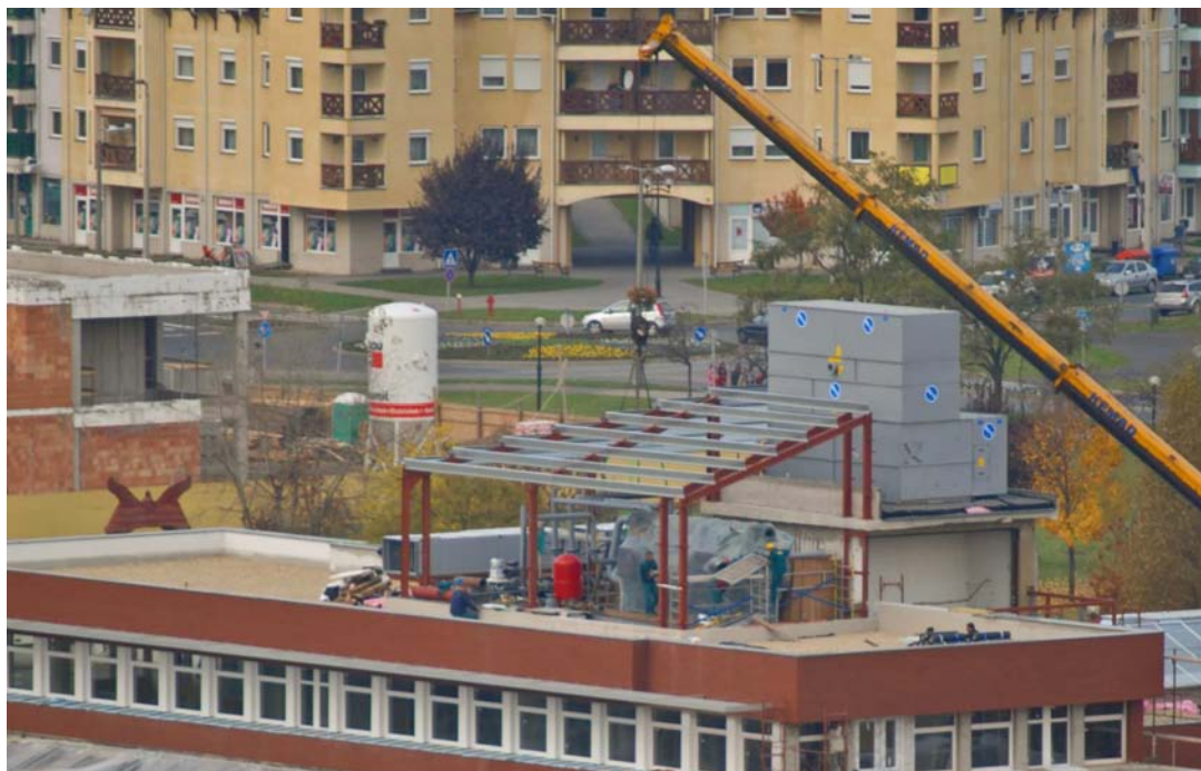
Az abszorpciós folyadékhűtő szerelése
