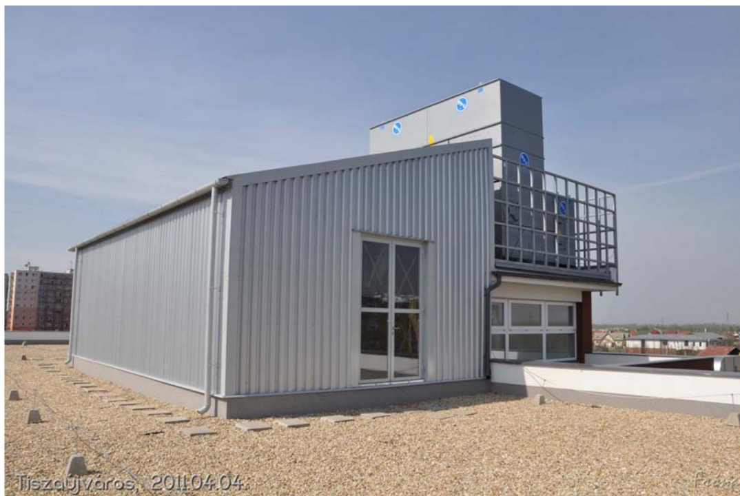
Az elkészült hűtőközpont (keleti oldal)
