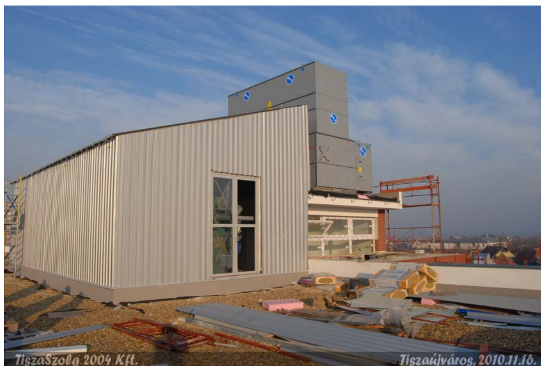
A hűtőközpont-felépítmény szigetelése, készre szerelése
