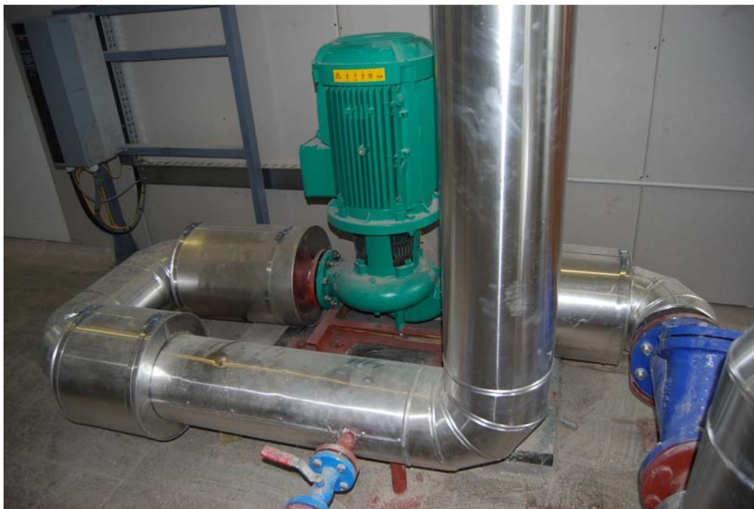
Szigetelési és bádogozási munkák elvégzése
