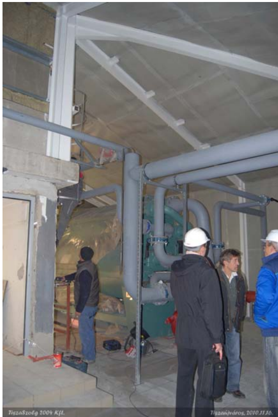
Az abszorpciós folyadékűtő szerelése
