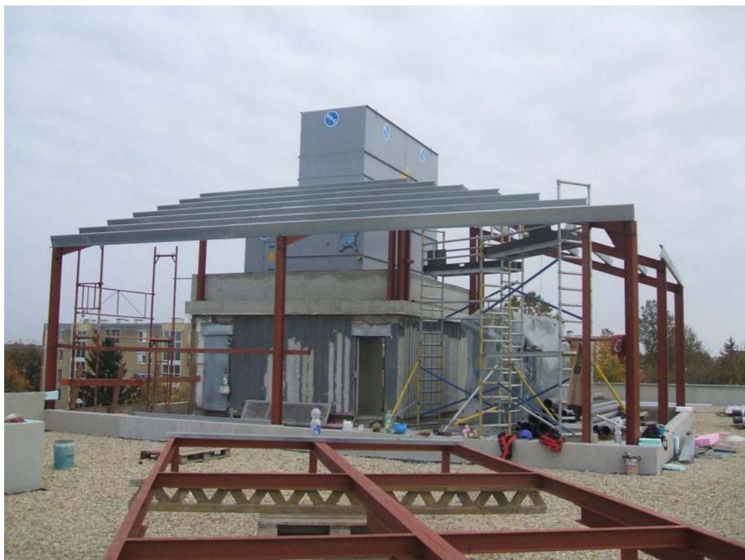
Az abszorpciós folyadékűtő szerelése
