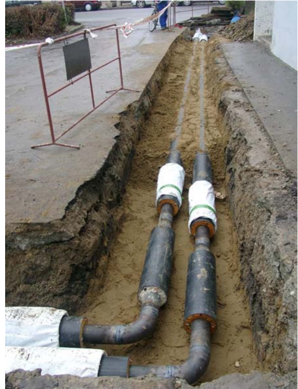
A távfűtési vezetékek összekötése
