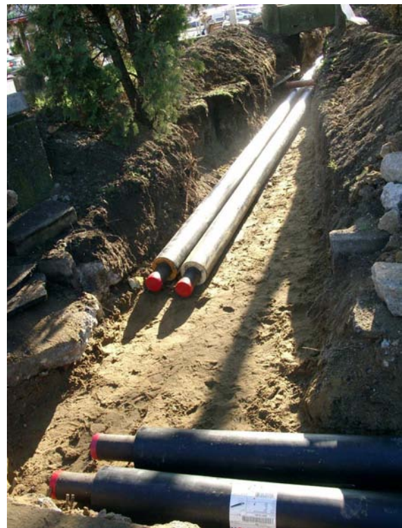
A távfűtési vezeték telepítése
