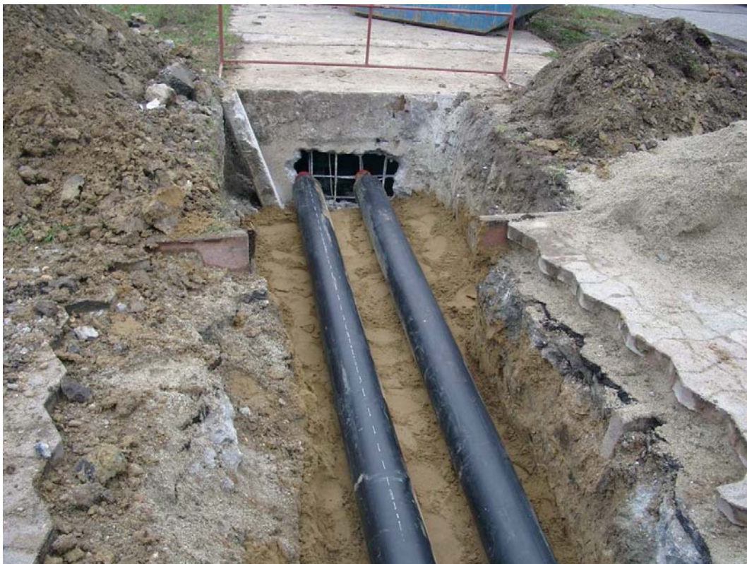
A távfűtési vezetékek telepítése
