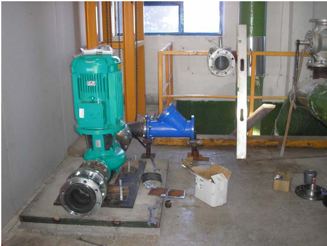
A szivattyú telepítése és szerelése
