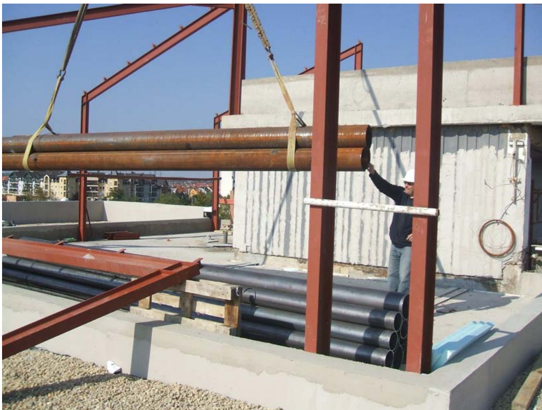
A csővezetékek tetőre helyezése
