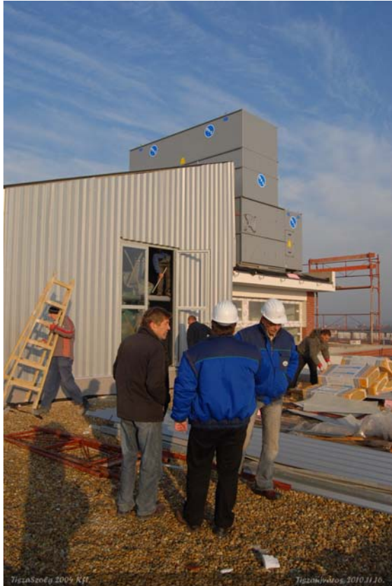
A hűtőközpont-felépítmény és hűtőtorony-tartószerkezet készre szerelése
