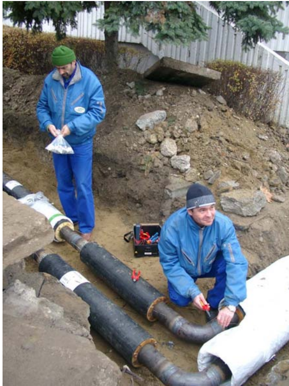
A távfűtési vezetékek összekötése
