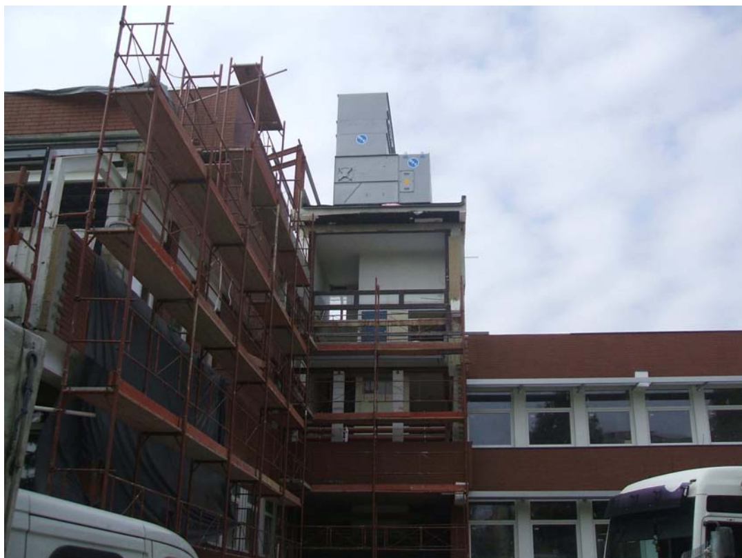
A hűtőtorony szerelése
