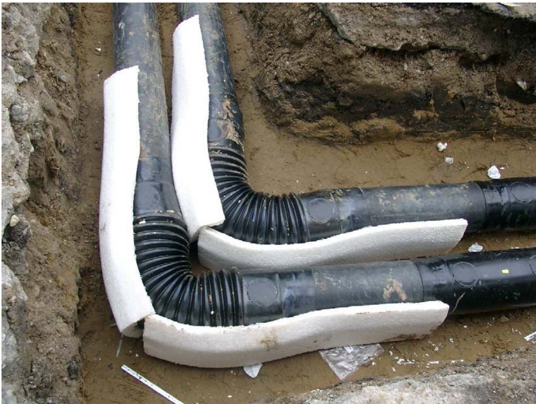
A távfűtési vezetékek takarás előtti állapota
