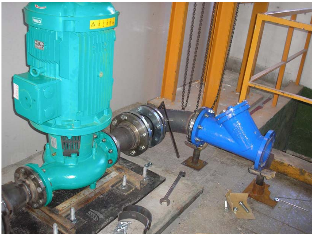
A szivattyú telepítése és szerelése
