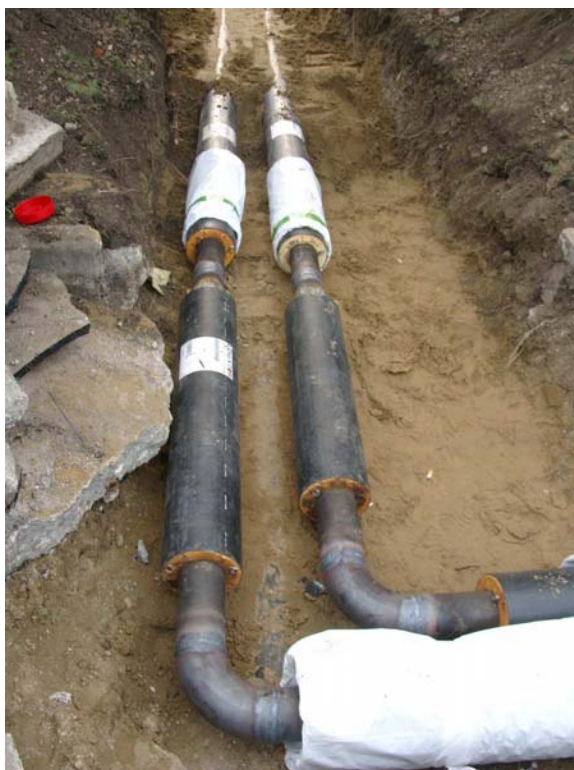
A távfűtési vezeték összekötése
