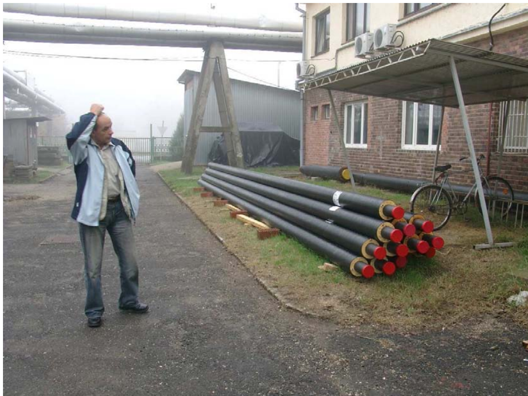
A beérkezett csővezetékek elhelyezése a telephelyünkön
