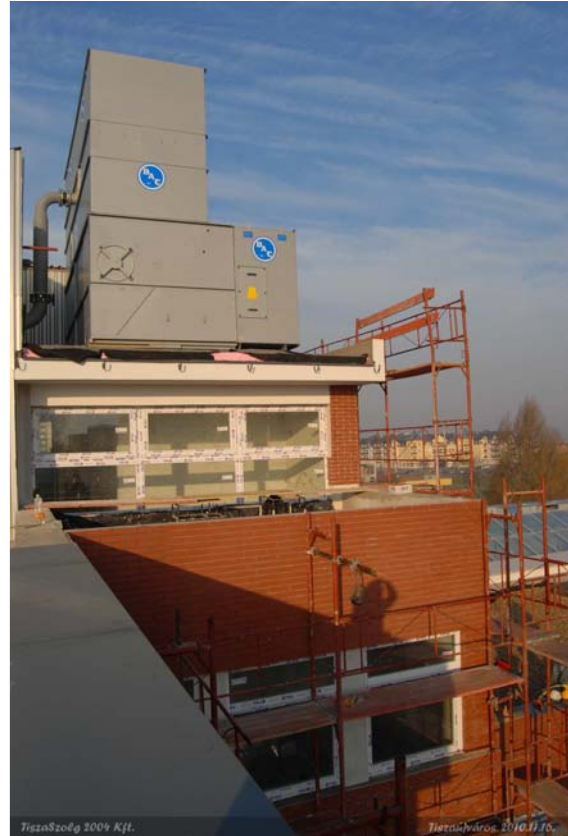
A hűtőközpont-felépítmény és hűtőtorony-tartószerkezet készre szerelése
