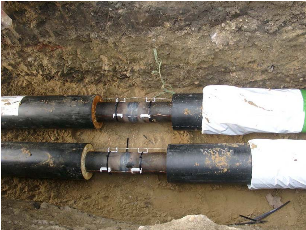
A távfűtési csővezetékek hegesztése, jelzővezetékek összekötése
