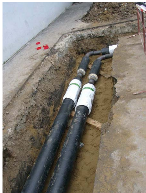
A távfűtési vezeték összekötése
