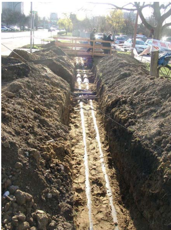
A távfűtési vezeték telepítése
