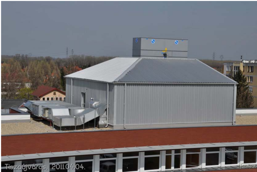
Az elkészült hűtőközpont (északi oldal)
