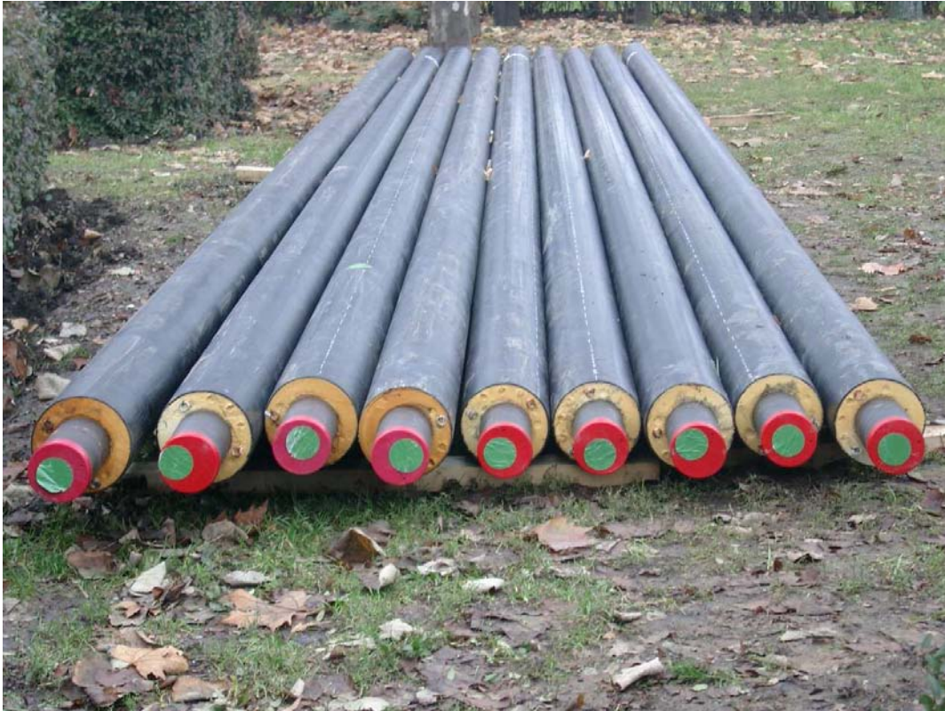
A távfűtési vezeték elhelyezése a helyszínen
